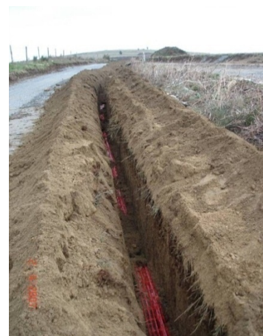
Illustration 11 : Réalisation de la tranchée et de la pose du câble simultanément
