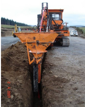
Illustration 11 : Réalisation de la tranchée et de la pose du câble simultanément
