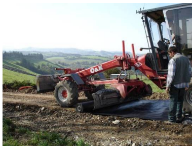
Pose du géotextile
