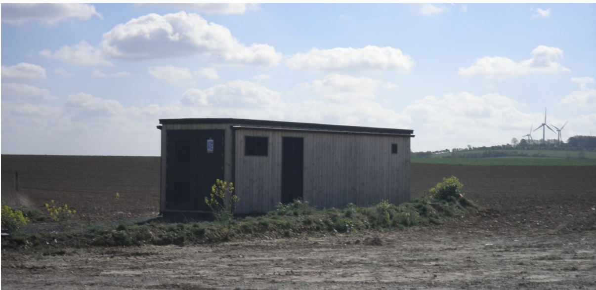
Illustration 8 : Exemple de poste de livraison qui sera mis en place
