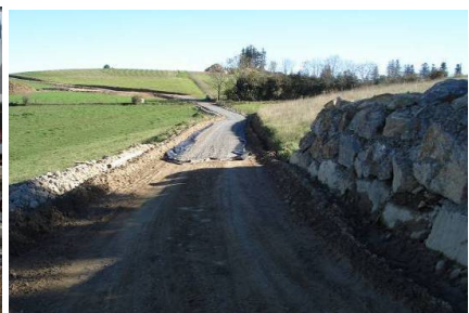
Mise en place du gravier
