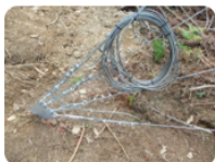
Ancrage des haubans au sol
