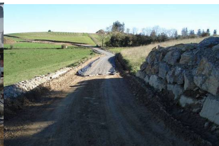
Mise en place du gravier
