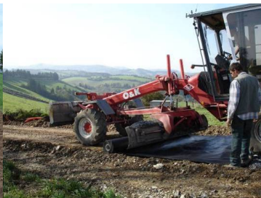
Pose du géotextile
