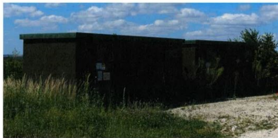
Figure 11 : Exemple de poste de livraison - RAL 7003 gris mousse (source : ATER Environnement, 2022)
